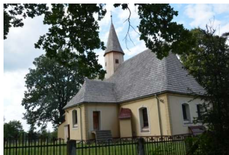
Fot. 7. Jeszkotle. Kościół filialny pw. św. Antoniego (fot. materiały Gminy Grodków).
