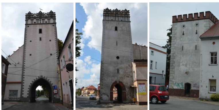
Fot. 20. Grodków. a) Wieża Bramy Lewińskiej, b) Wieża Bramy Ziębickiej, c) Baszta Więzienna (fot. materiały Gminy Grodków).
