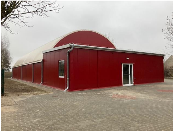
Fot. Sala gimnastyczna przy szkole podstawowej Lipowej
