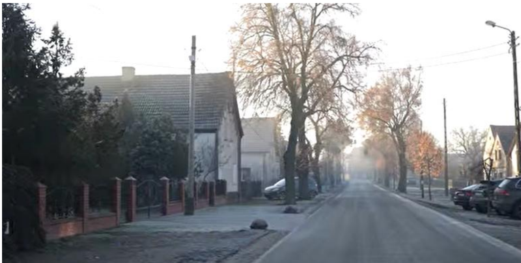
Więmierzycy - teren po budowie kanalizacji sanitarnej i pracach odtworzeniowych
